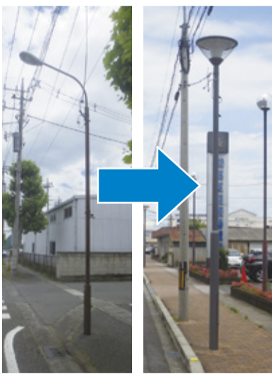
街路灯を水銀灯からLEDに改修
